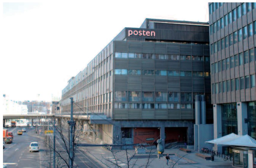
Bygningen sett fra vest med felles forplass til Høy- og Lavblokken. Fasaden er av ekstrudert aluminium. Valget av fasade ble gjort ut fra ønsket om et enkelt vedlikehold. Foto: Nils Midtbøen
