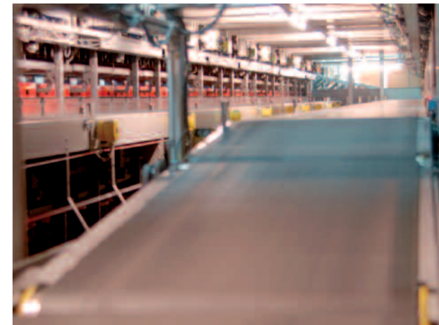
14. Storbrevmaskin i 4. etasje, sett fra innsiden.
