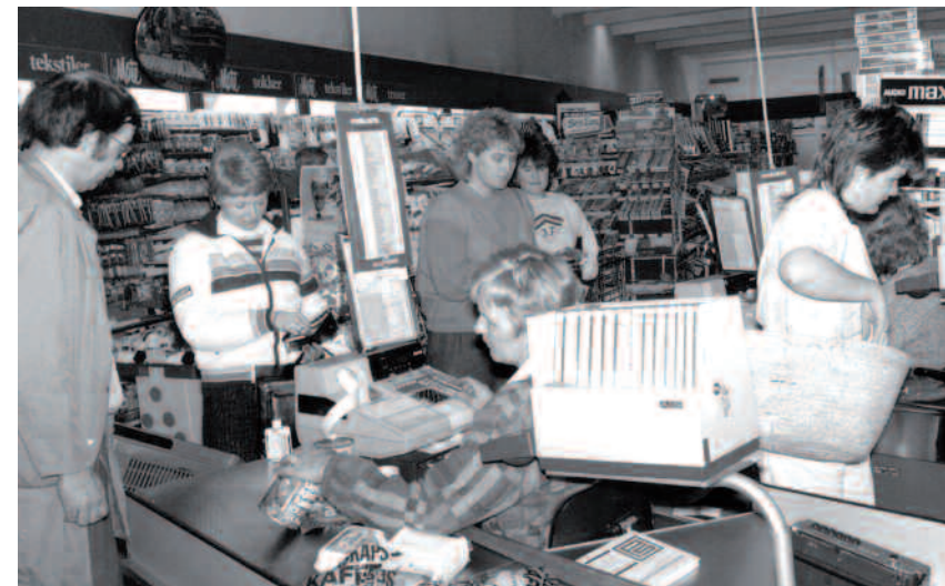
I butikken i Velferdsetasjen ble det solgt alt fra sytråd og parfyme til bakerverer og klær. Dette lettet hverdagen for de som arbeidet i bygningene. Foto: PPFfinans
