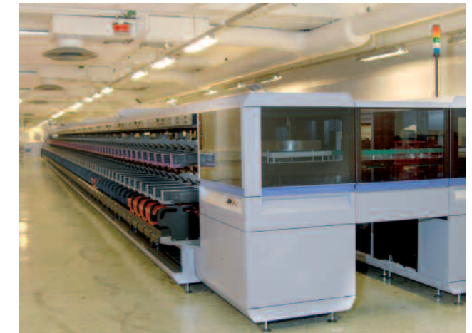
2. Nye brevsorteringsmaskiner innstalleres i øvre kjeller.
