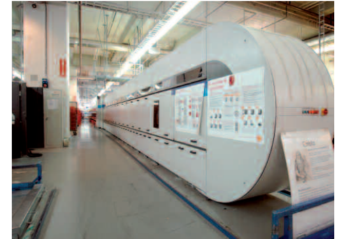
13. Sorteringsmaskinen «Embla» for sortering av store brev, 4. etasje.
