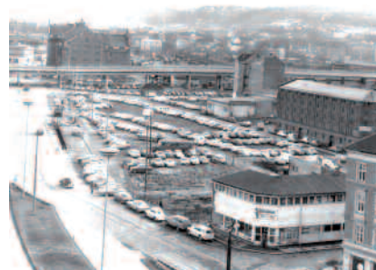
Oversikt over tomten etter at bygningene var revet. I bakgrunn Nylandsbroen og Tollboden. Foto: Postmuseet
