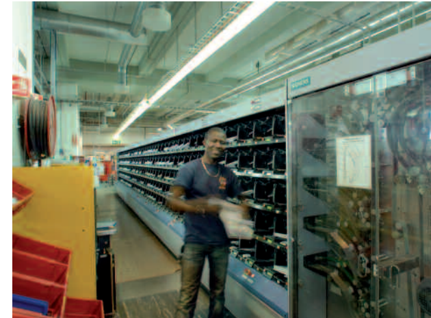
12. Maskinell finsorteringsmaskin i 4. etasje.
